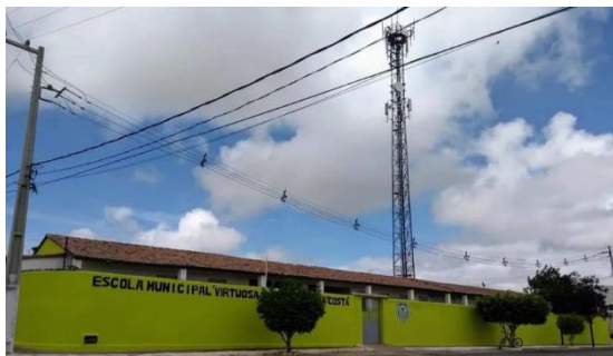
Figura 1 – Fachada da Escola Municipal Virtuosa Bernardina da Costa
