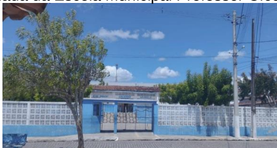
Figura 2: Fachada da Escola Municipal Professor Cícero Varela
